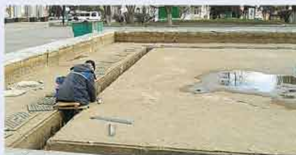
Рабочие уже начали подготовку фонтана
